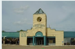
ISC – Core 1 (data center)
